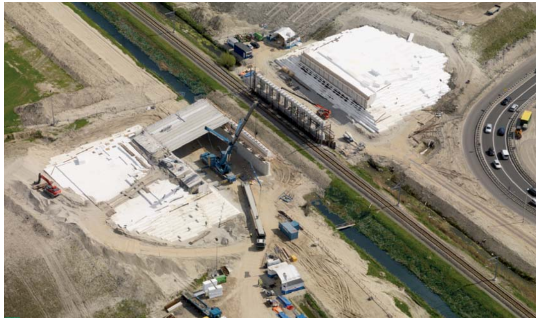
Figuur 5 Waarborgen van een terp op zachte ondergrond [U8].
