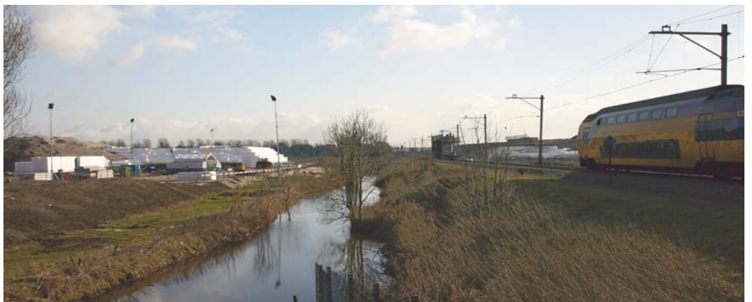
Figuur 7 Werk in uitvoering tijdens de realisatie van de viaduct van de N207 over de spoorlijn Alpen a/d Rijn-Gouda.
