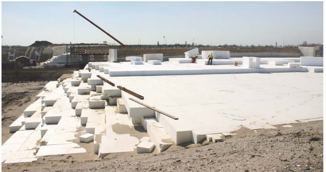
Figuur 6 Werk in uitvoering tijdens de realisatie van de viaduct van de N207 over de spoorlijn Alpen a/d Rijn-Gouda.
